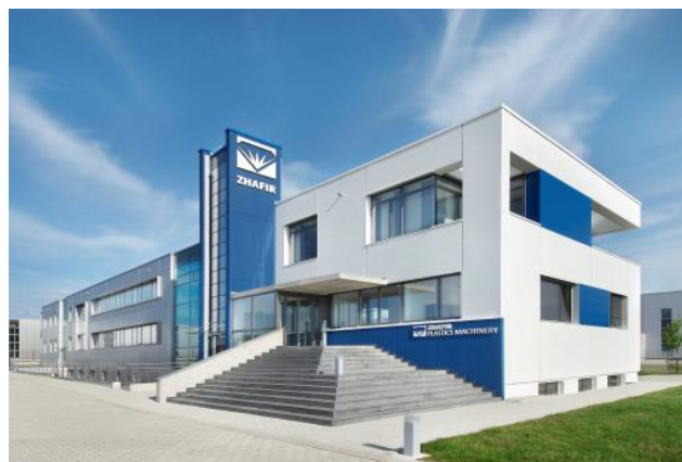
Конструкторское бюро ЗАФИР в г. Эбермансдорф Германия
